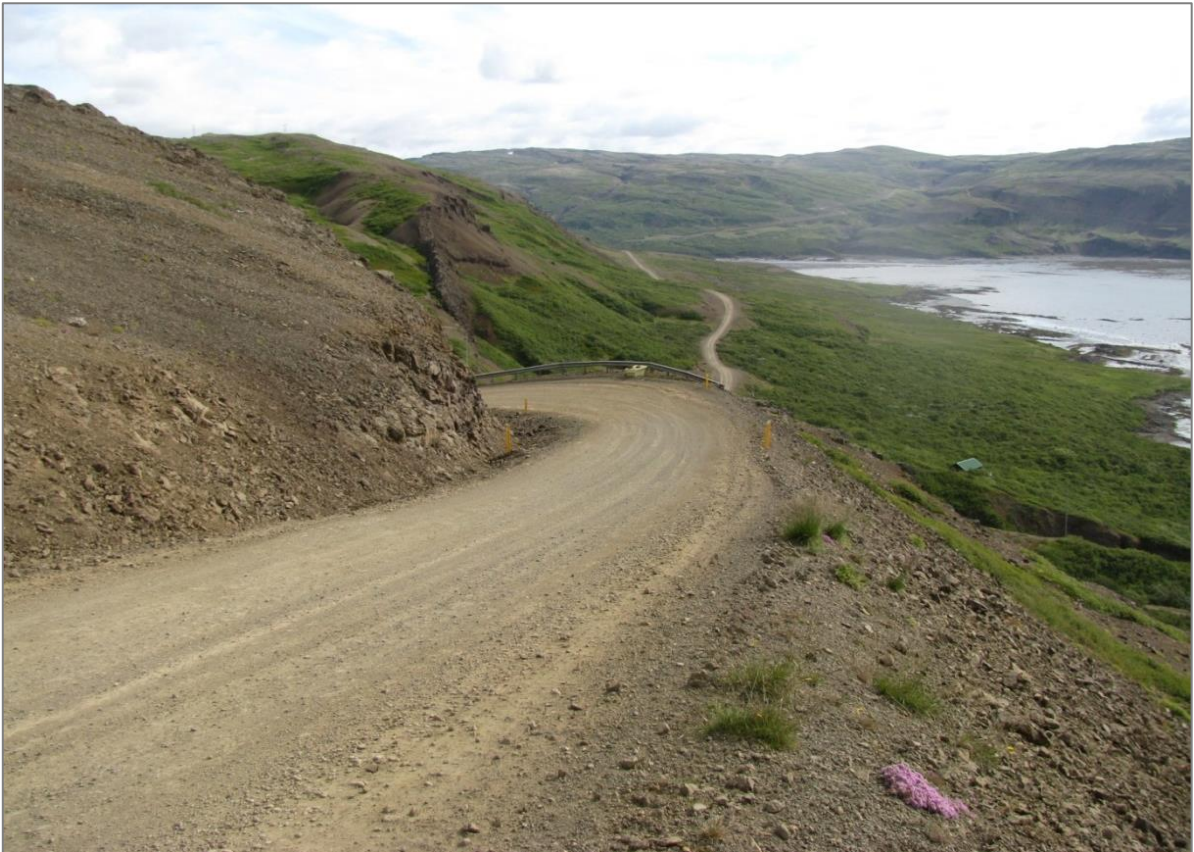
Mynd 25. Kröpp beygja á núverandi vegi á Ódrjúgshálsi Djúpaþfjarðarmegin (ljósmynd: Helga Aðalgeirsdóttir, 2012).
